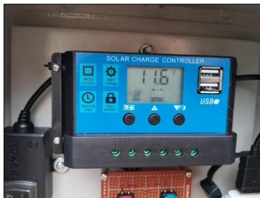
Gambar 5.4 Implementasi SCC pada Pompong Laut
