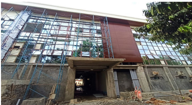
Gambar Pekerjaan Pintu dan Jendela
