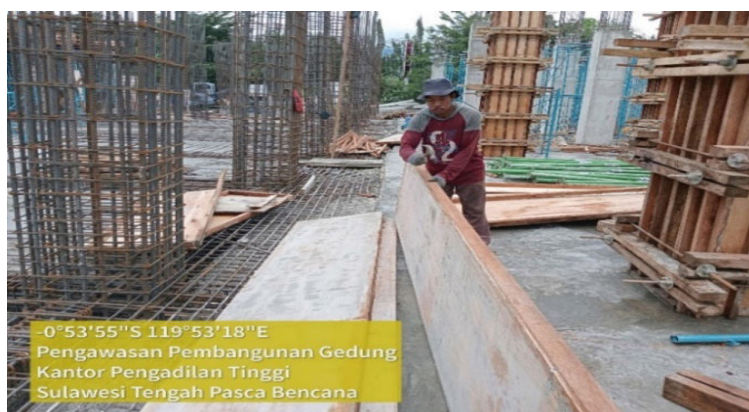
Gambar Pekerjaan bekisting
