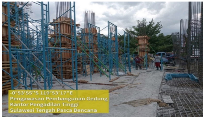
Gambar Pekerjaan scaffolding
