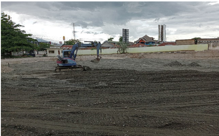
Gambar Pekerjaan urugan tanah
