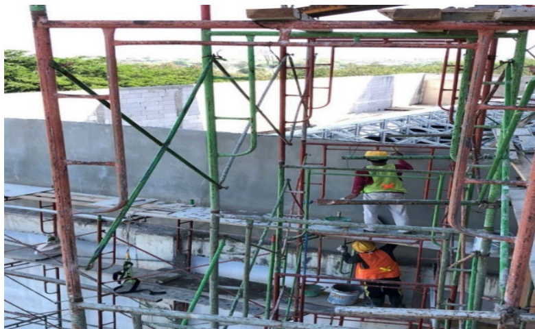
Gambar Pekerjaan pasangan dan plesteran
