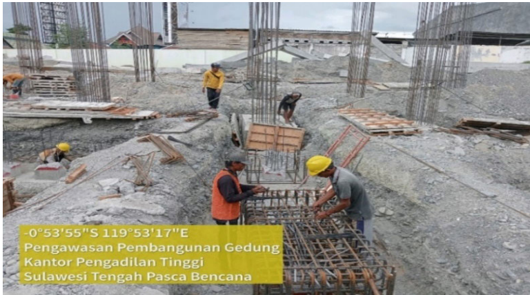
Gambar Pekerjaan pondasi
