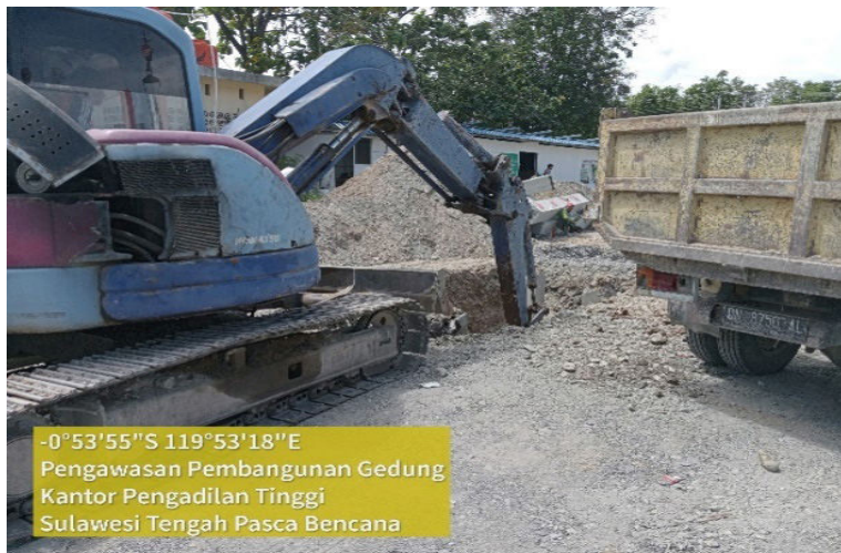
Gambar Pekerjaan galian tanah
