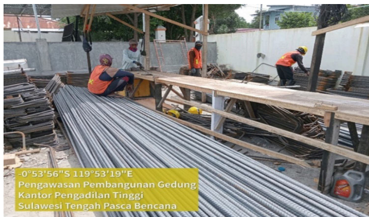
Gambar Pekerjaan pembesian
