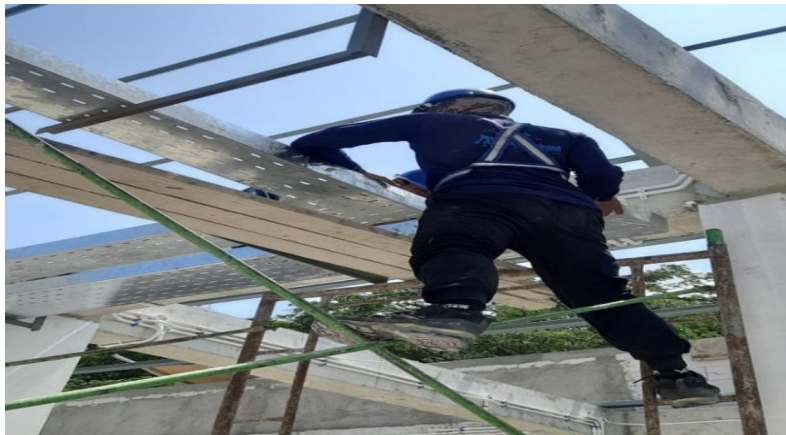
Gambar Pekerjaan Sistem Mekanikal Elektrikal dan Plumbing (MEP)
